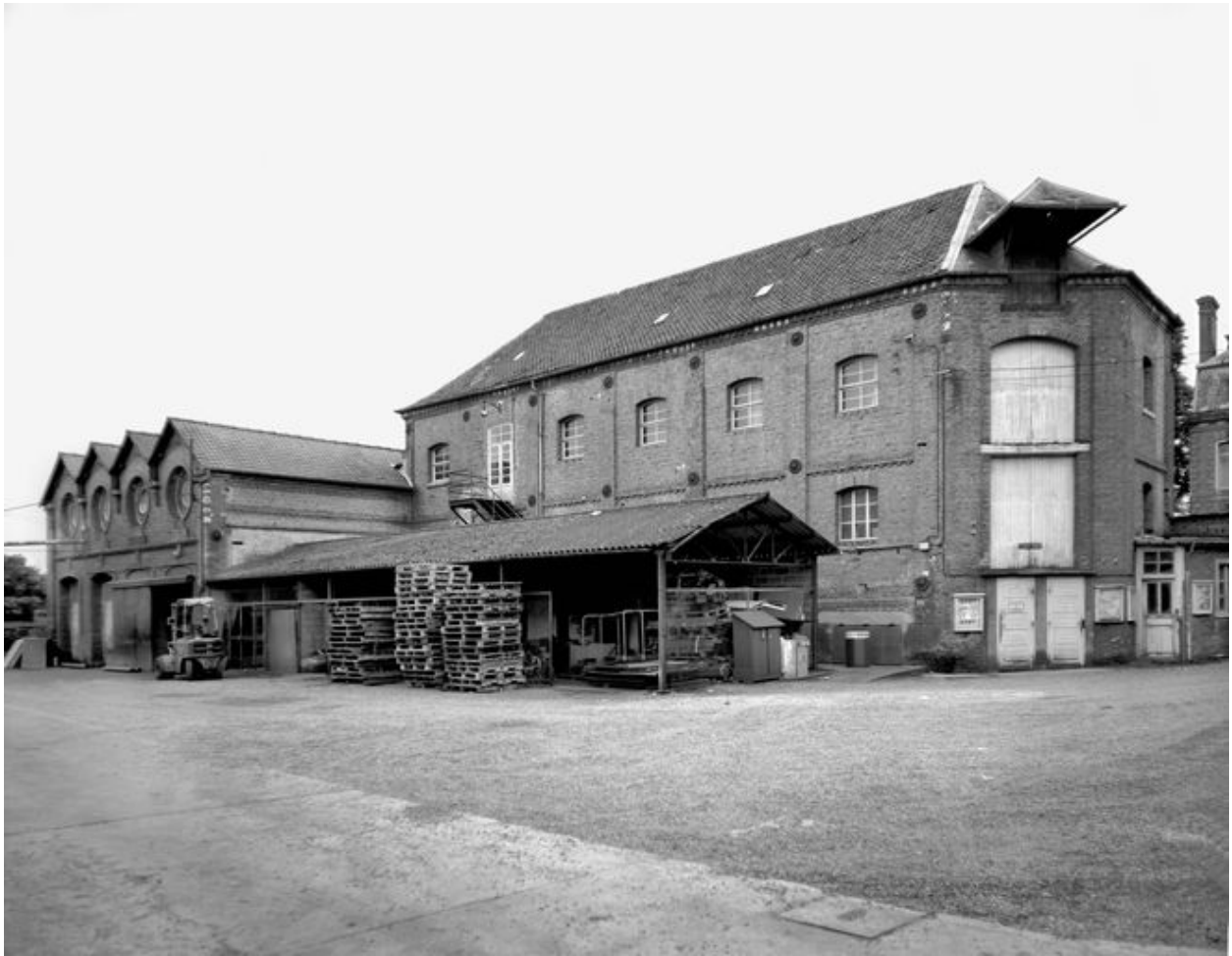
Façade sur cour d'un atelier de tissage et de l'ancienne chaufferie. Etat en 1988.
