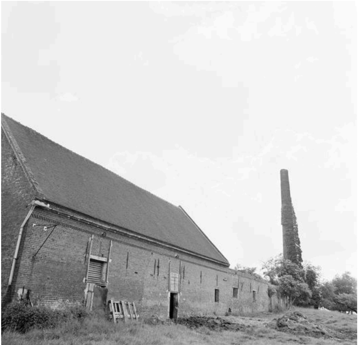
Atelier de fabrication et cheminée d'usine.
