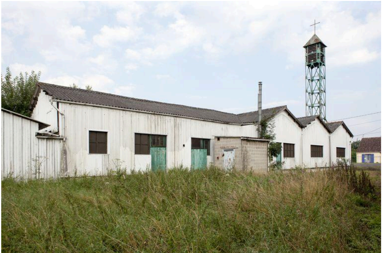
Vue du flanc droit de la nef et salle paroissiale.
