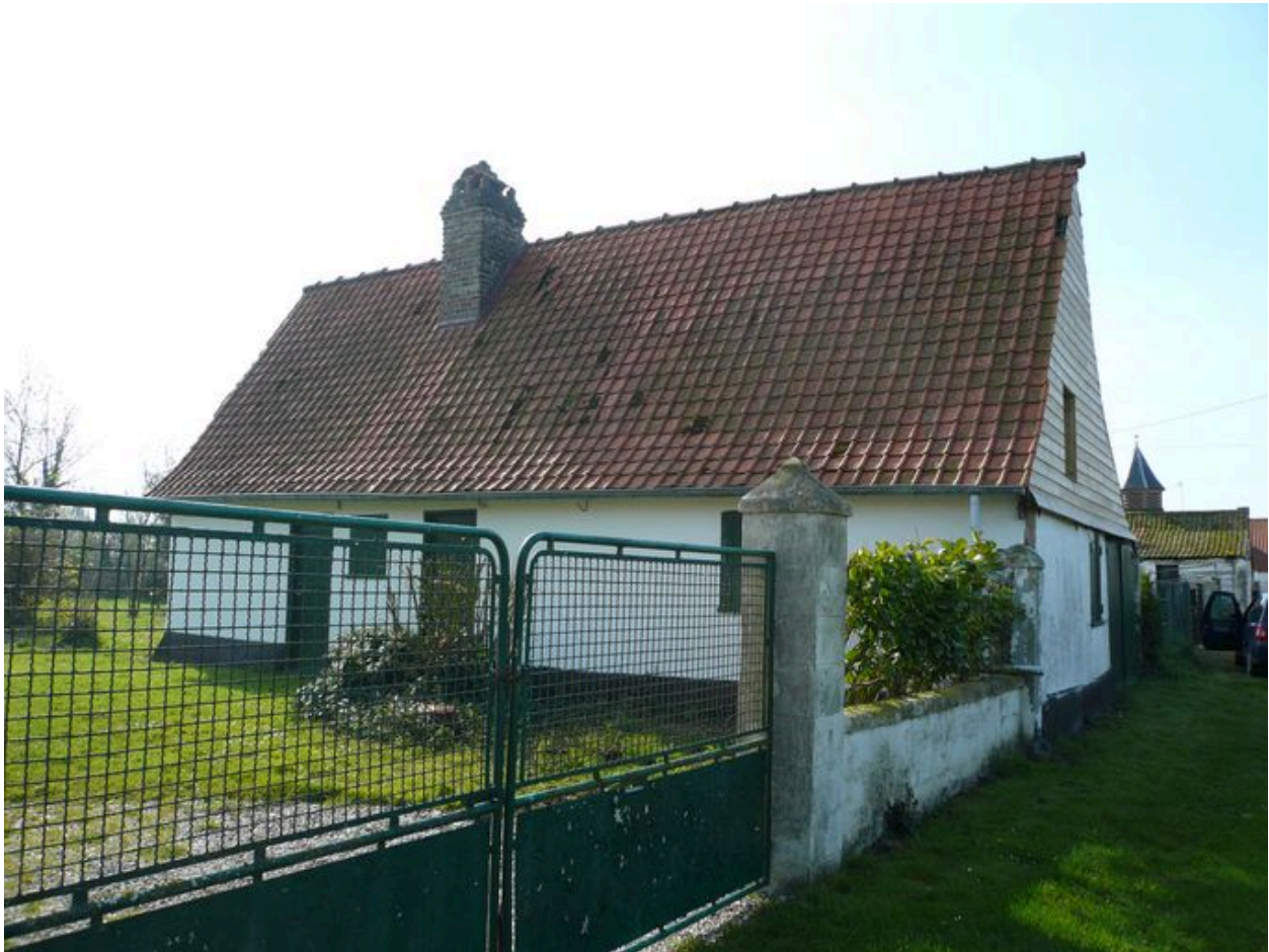
Vue des étables au sud.
