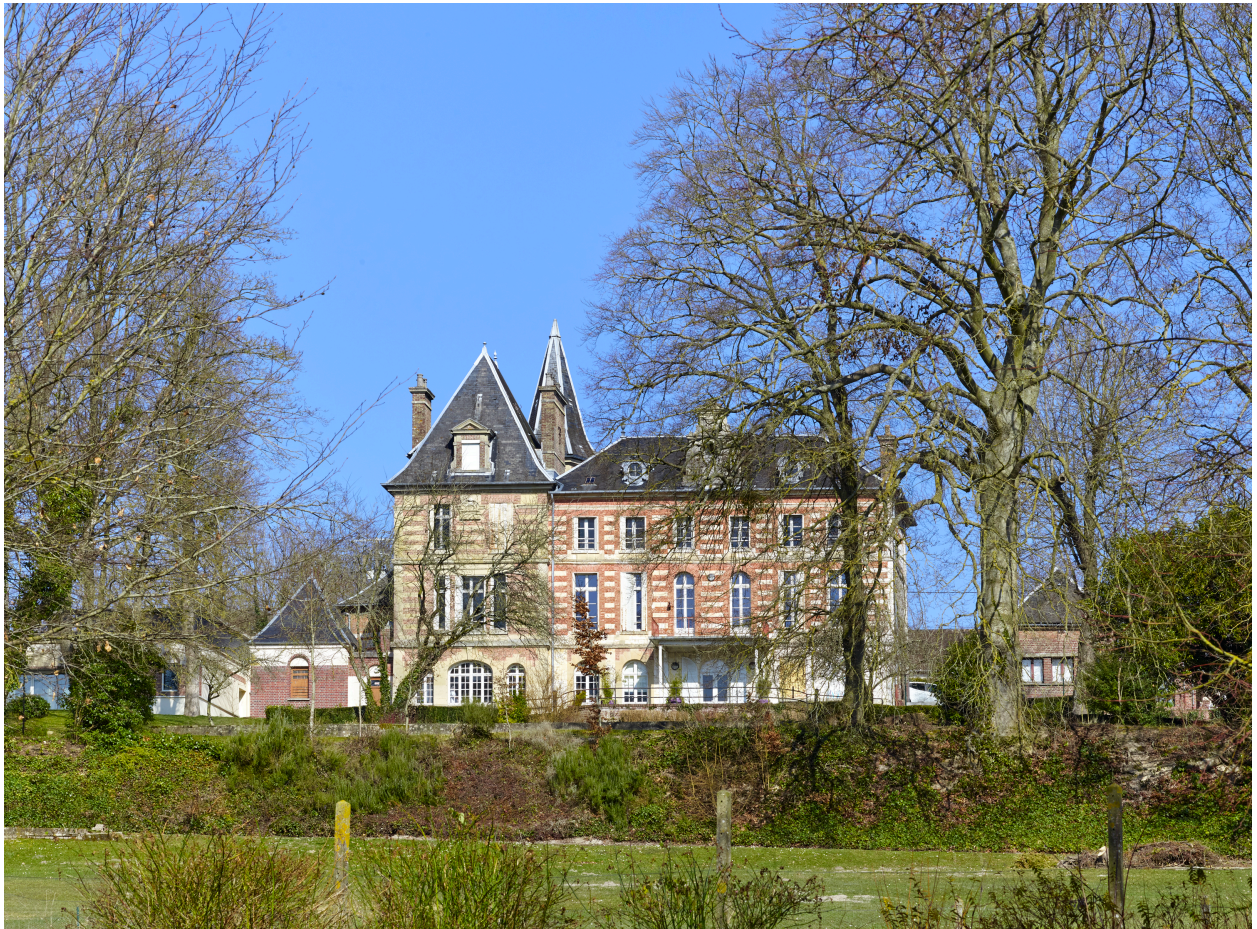
Vue sud de la demeure, depuis le parc.
