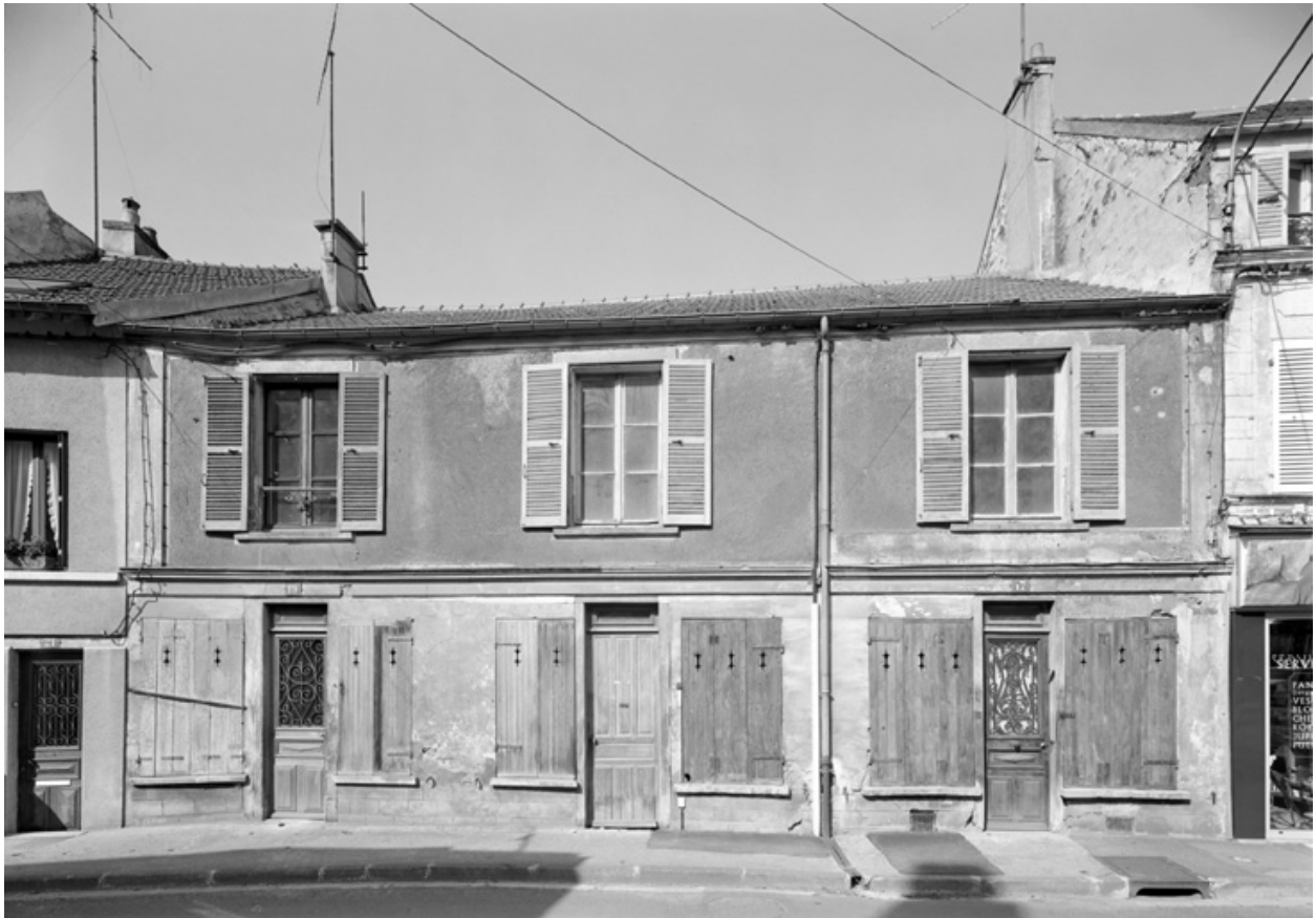
Vue de la façade sur rue.
