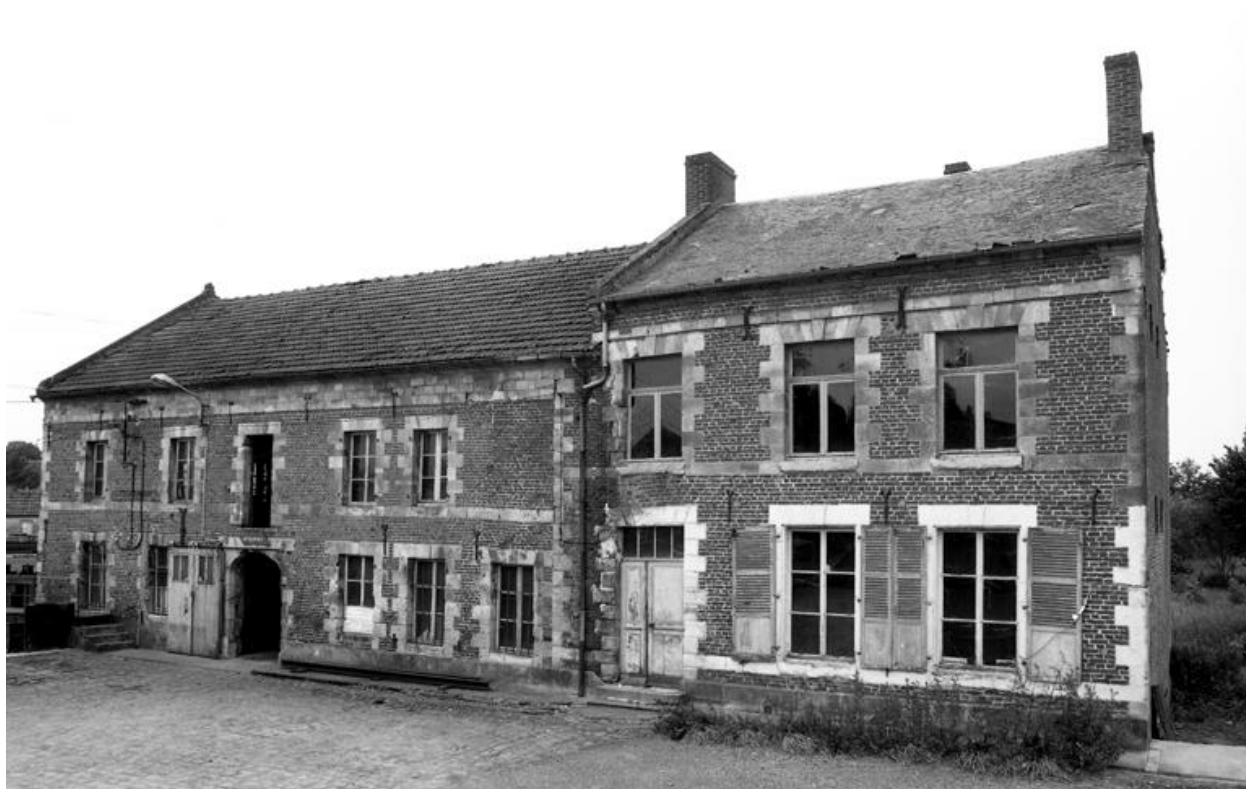
Vue de la façade du bâtiment principal.
