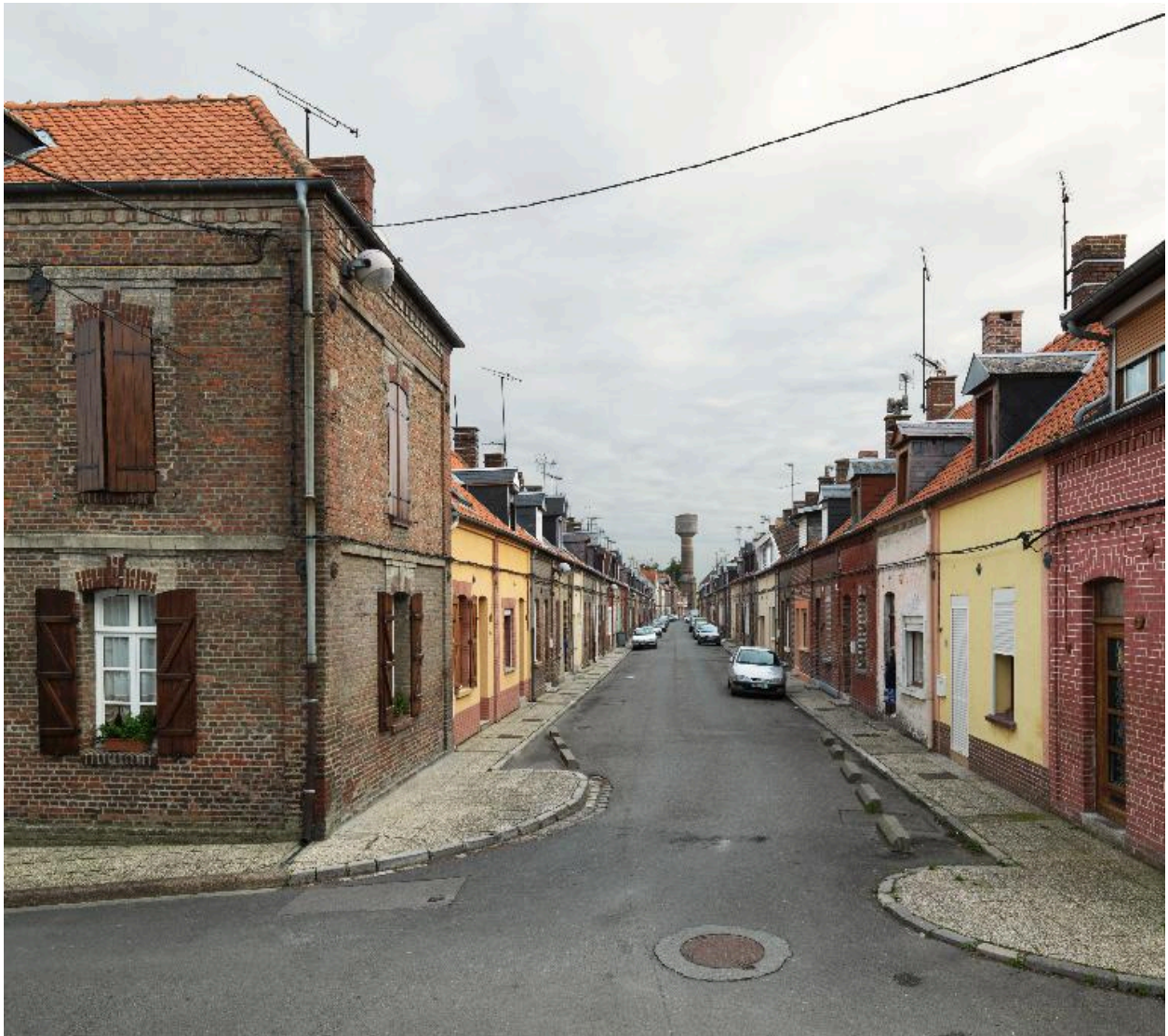
La rue Docteur-Jean-Martin, vue vers l'est, depuis l'ancienne maison de contremaître.
