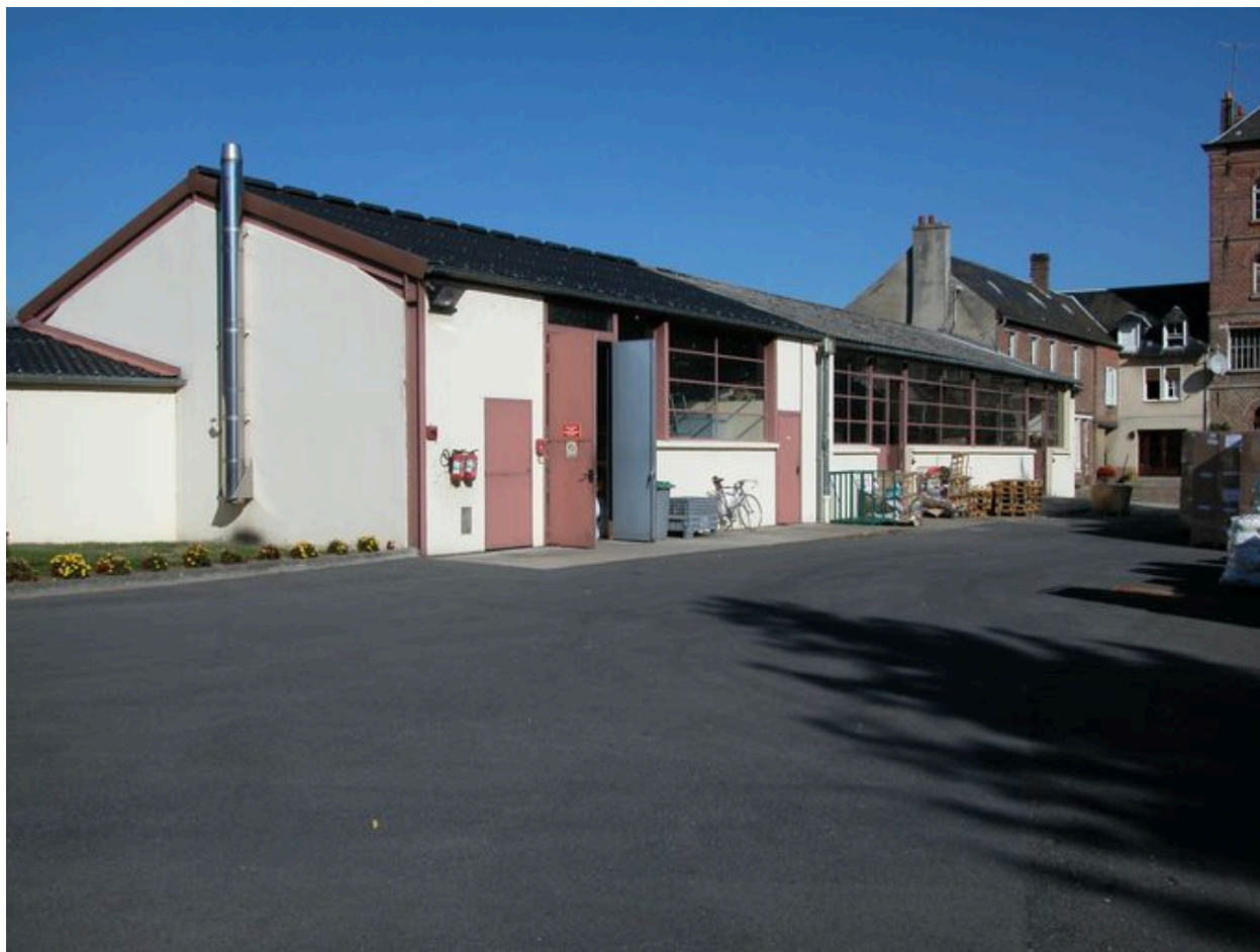
Atelier de fabrication construit en 1965.
