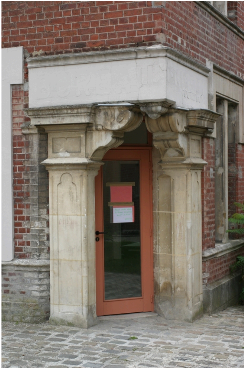
Entrée des anciens bureaux.
