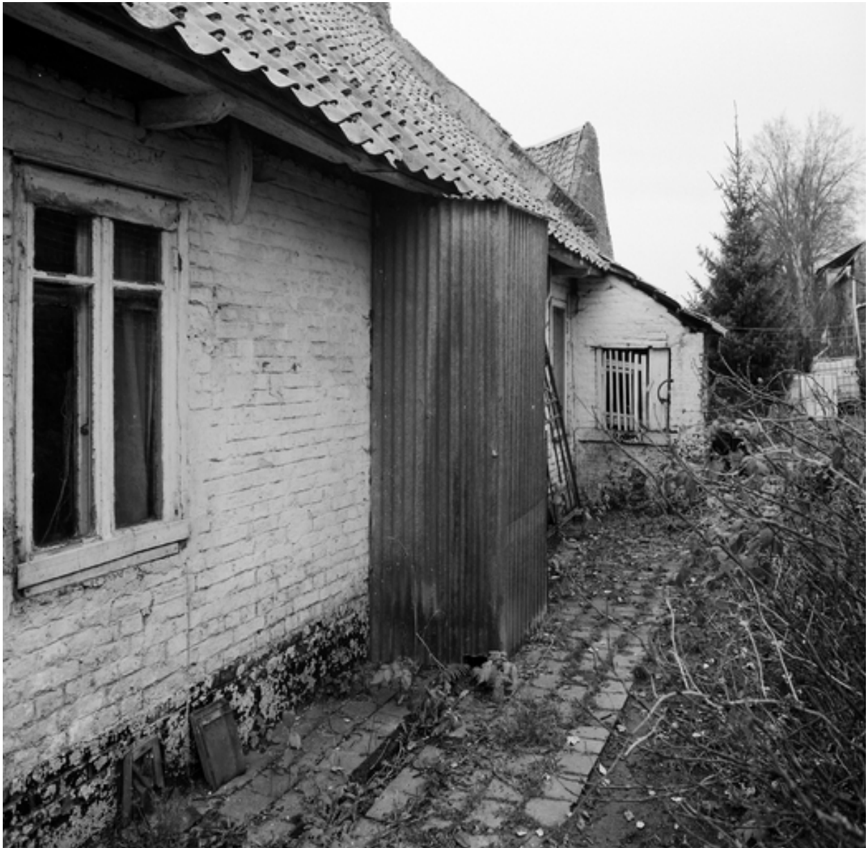
Vue générale du puits D.
