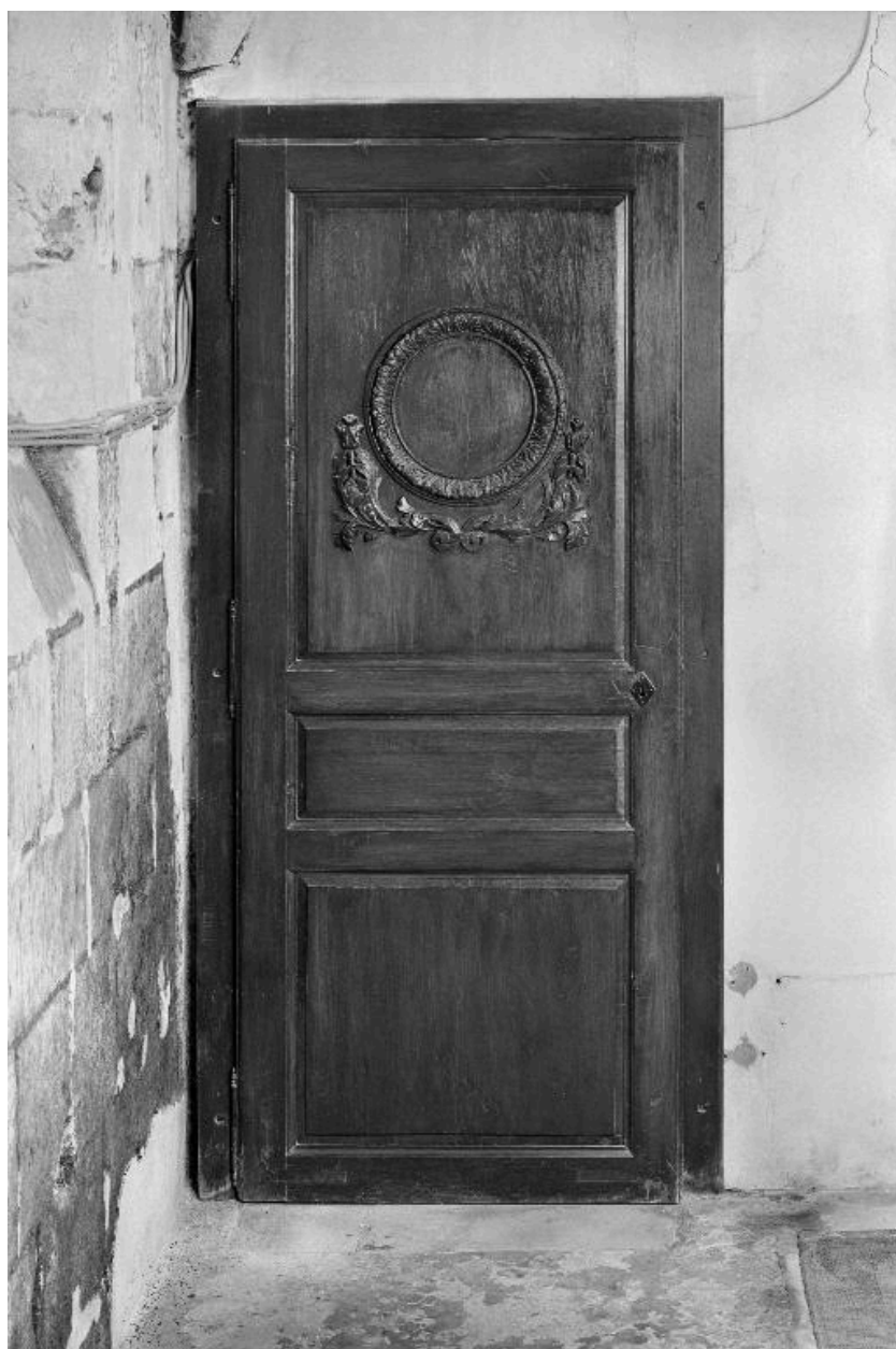
Vue du vantail de la porte qui donne sur la sacristie.
