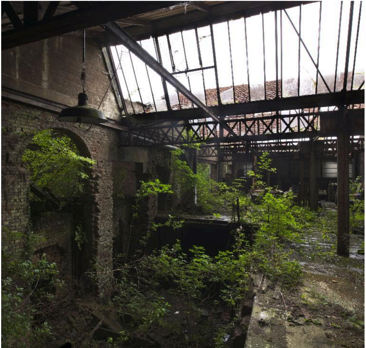
Vue des anciens fours et des ateliers de fabrication.
