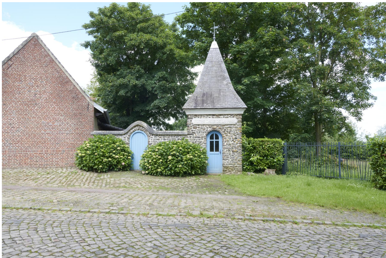
Vue de face. Depuis l'est.
