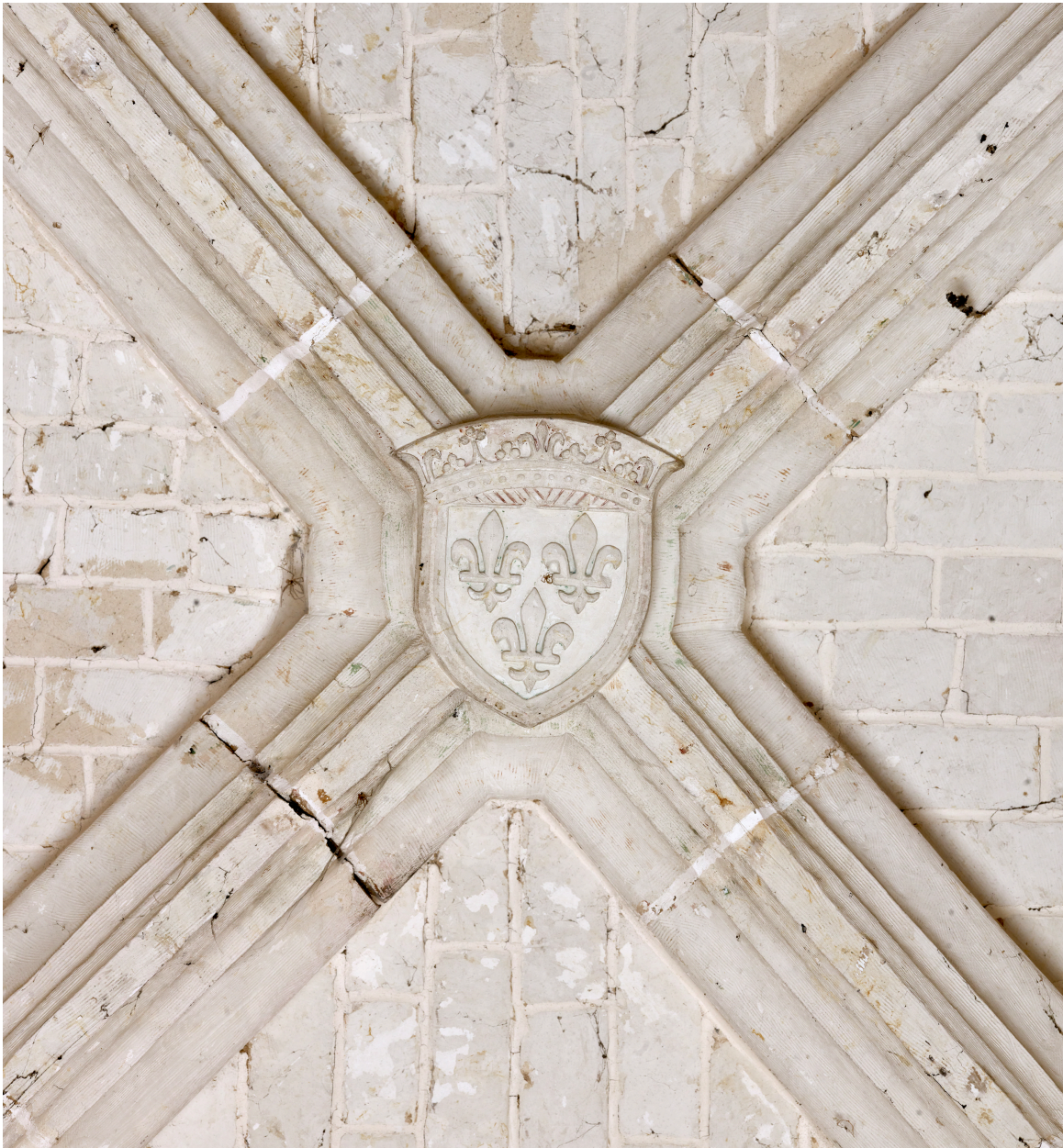
Intérieur, clé de voûte de l'ancienne croisée du transept.
