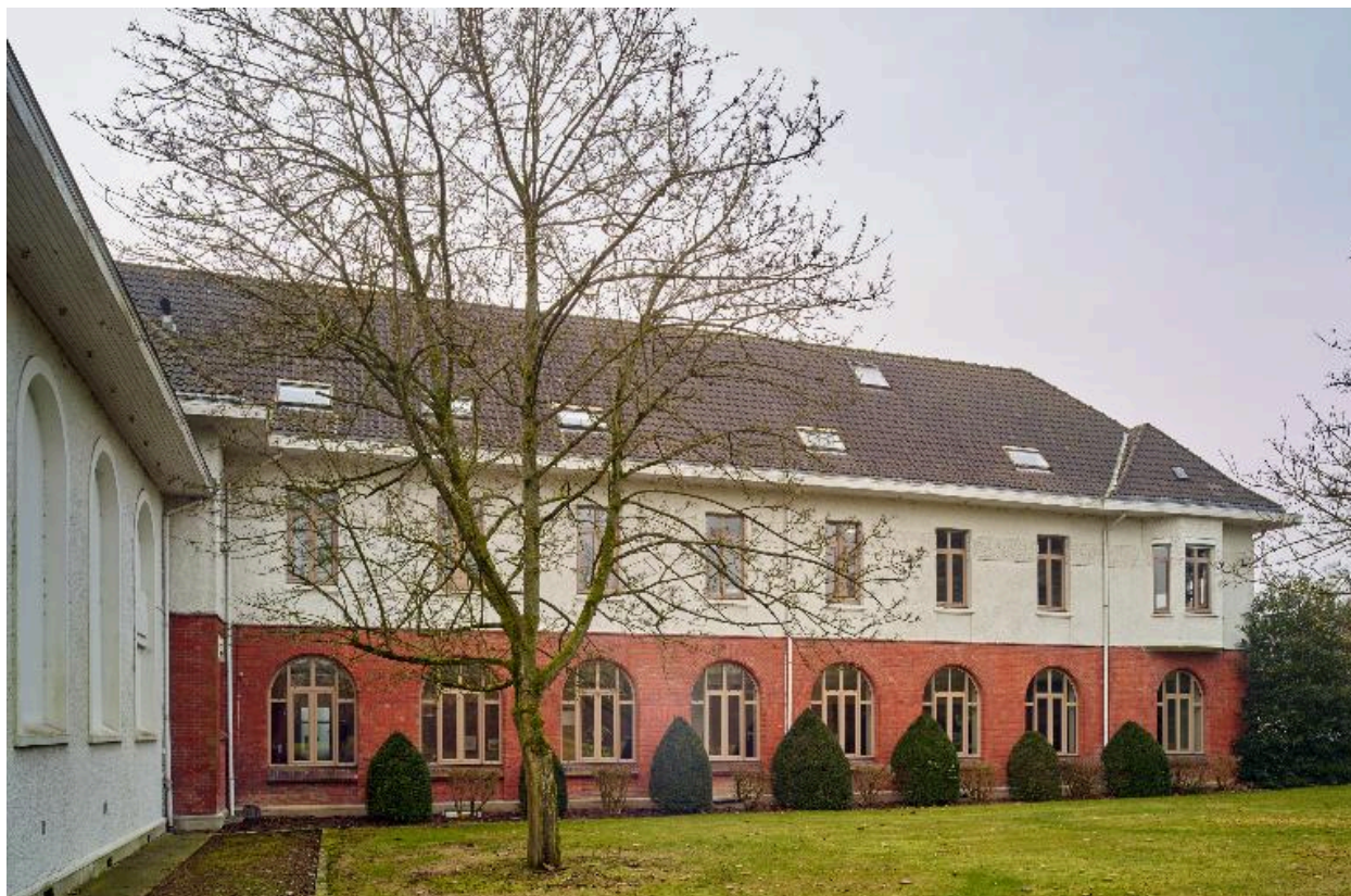
Bâtiment de l'administration, élévation postérieure, détail de la partie gauche, vue prise de face.
