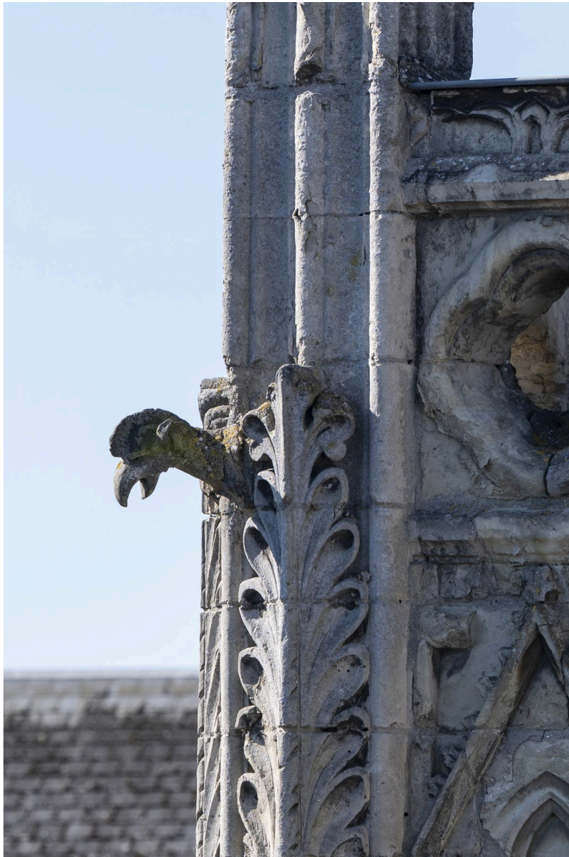
Détail d'une gargouille en forme de rapace située sur les contreforts.
