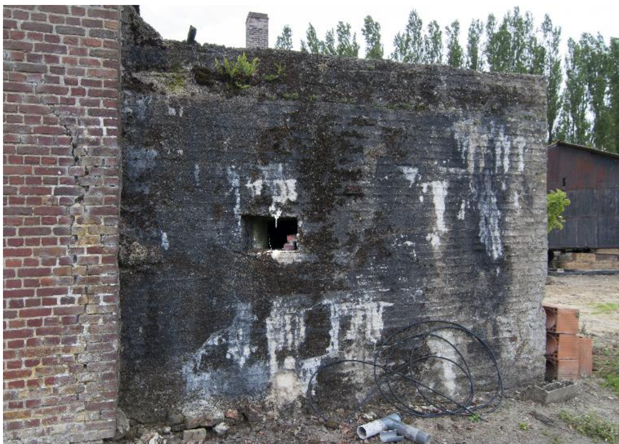
Casemate B, vers le sud-ouest
