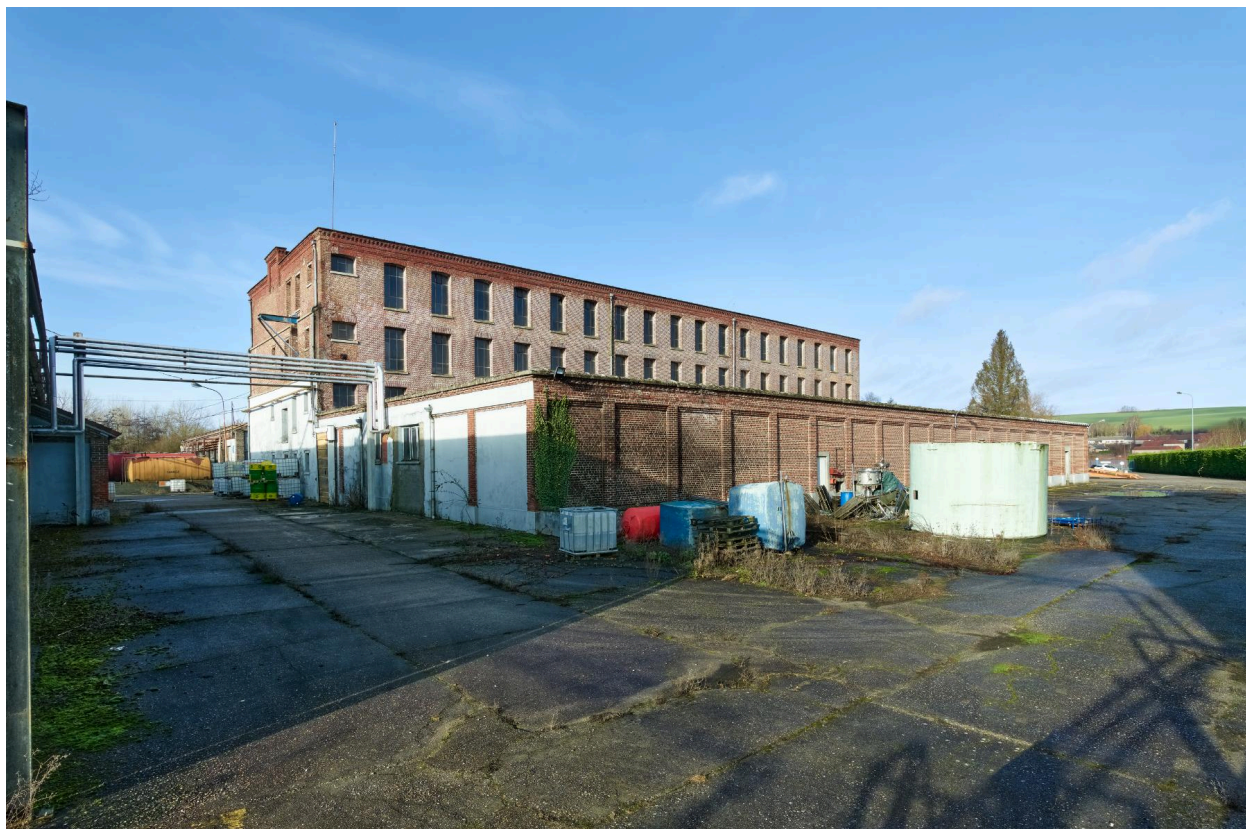
Bâtiment A, vue d'ensemble depuis le sud-est.
