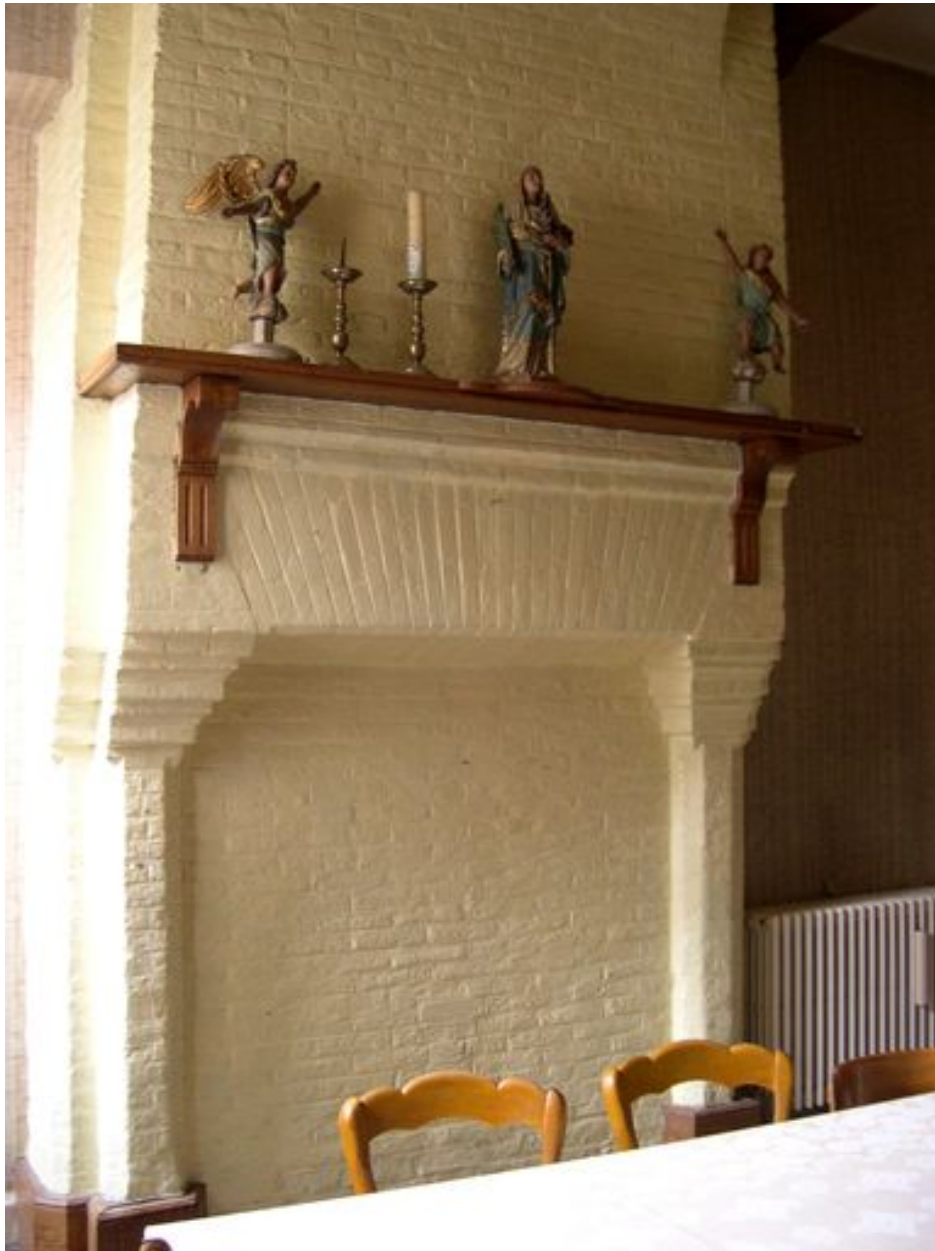
Intérieur, rez-de-chaussée, pièce nord-est : manteau de cheminée.
