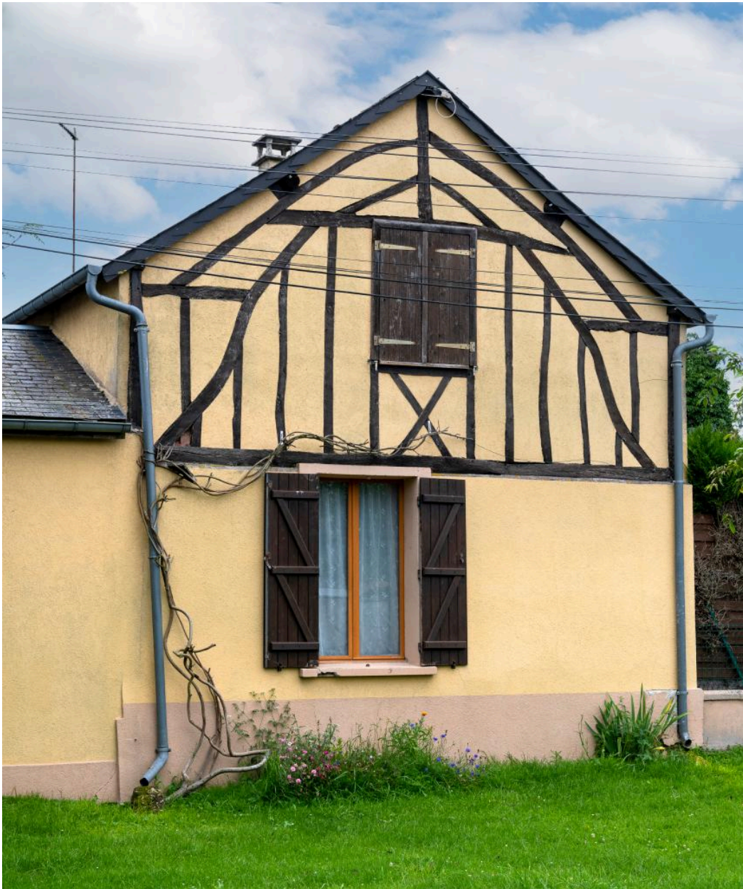
Pignon avec pans de bois apparents au n°52 rue Principale, vue depuis l'est.
