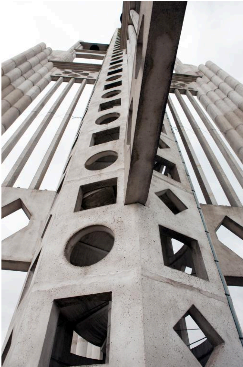
Campanile. Vue en contre-plongée de la cage d'escalier menant aux cloches.
