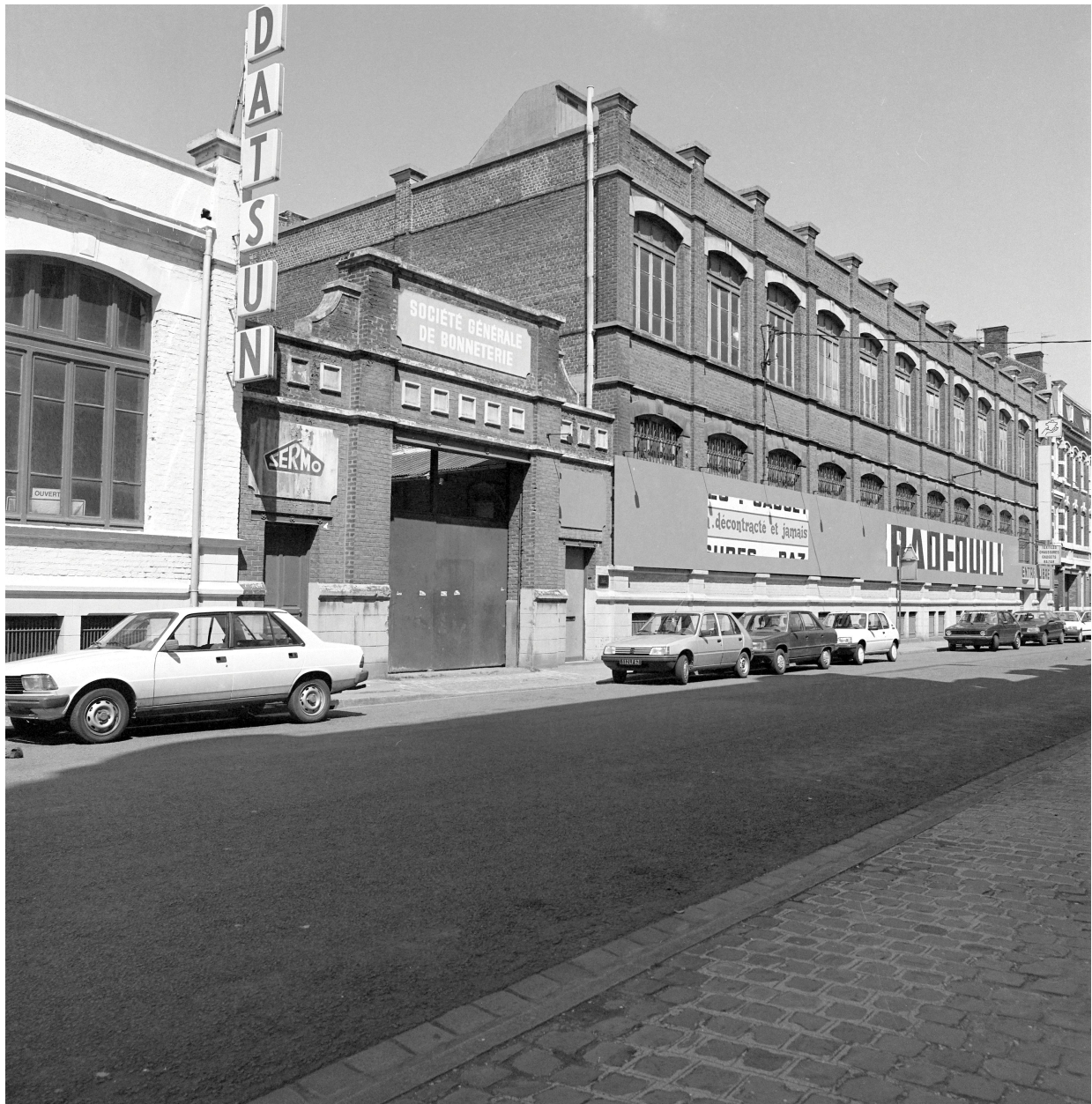
Élévation rue Nationale.
