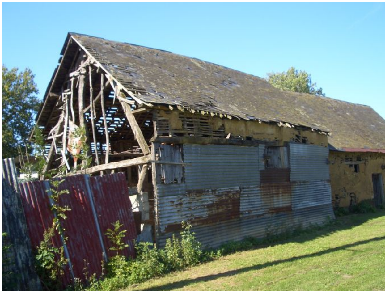
Vue de la grange.
