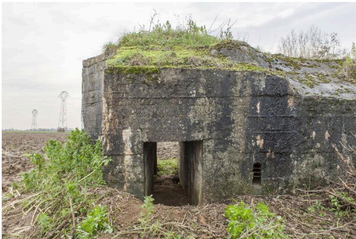
Entrée nord et couloir de distribution en enfilade
