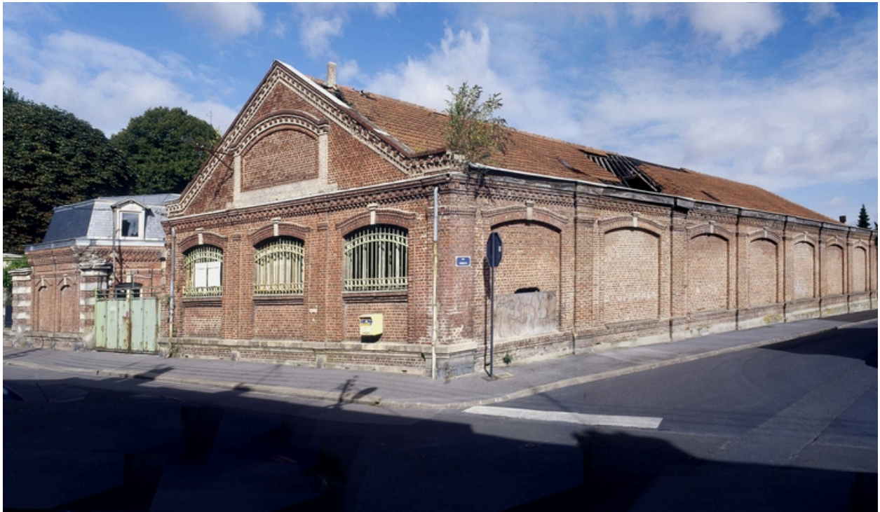
Façade des ateliers rue Sommières, rue Camille Desmoulins.
