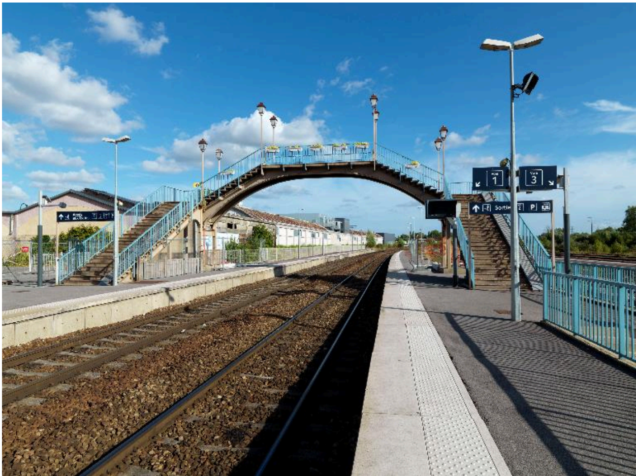
Passerelle avant sa transformation fin 2016-début 2017.
