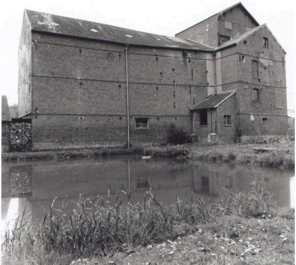
Vue d'ensemble de la minoterie.
