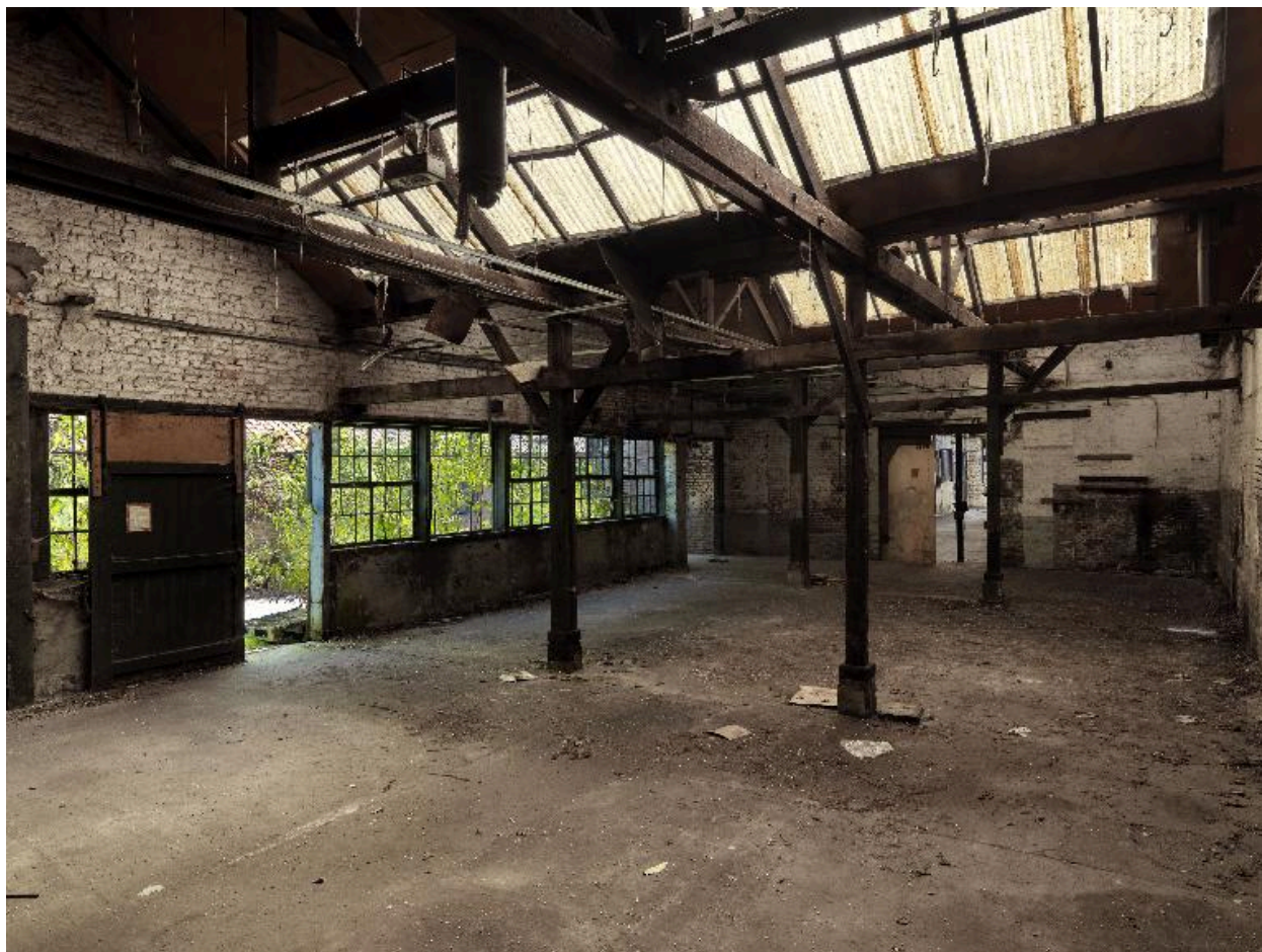
Ancien atelier de fabrication secondaire.
