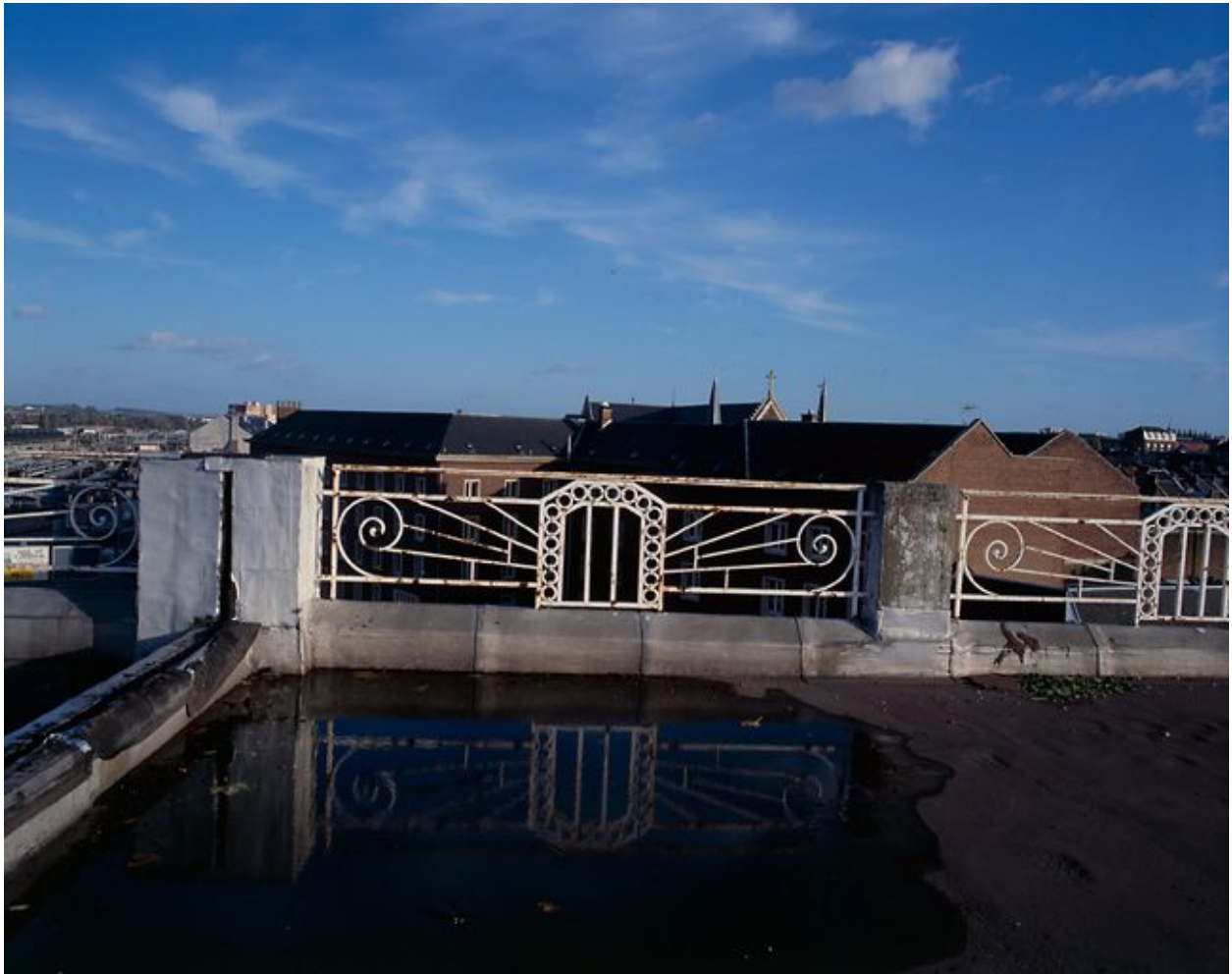
Détail de la balustrade bordant la terrasse.
