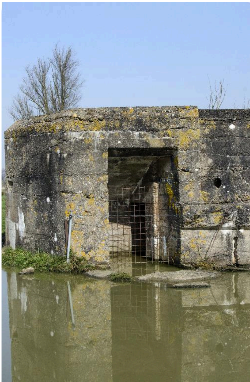
Elévation sud, entrée ouest
