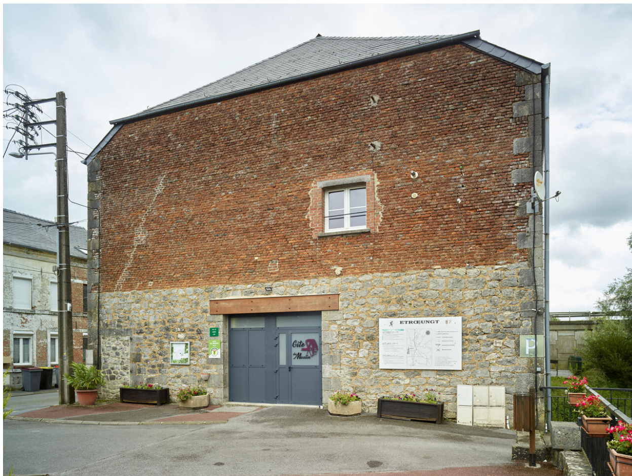
Le magasin à laines, pignon ouest.
