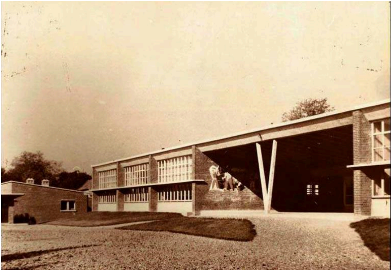
Façade sud de l'ancien groupe scolaire de l'Etoile, 1953 (coll. J. Hérouart).
