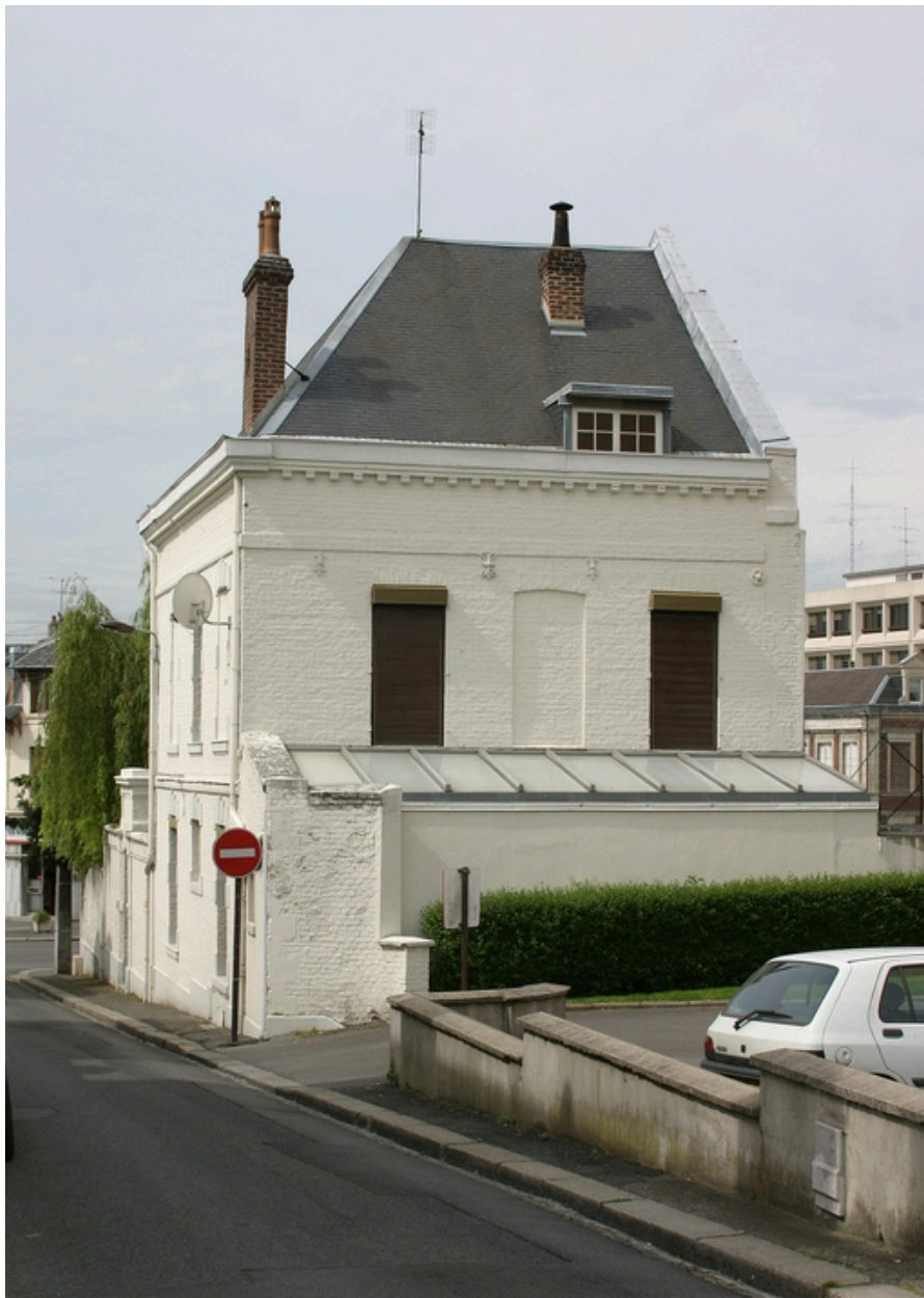
Façade antérieure des anciens bureaux.
