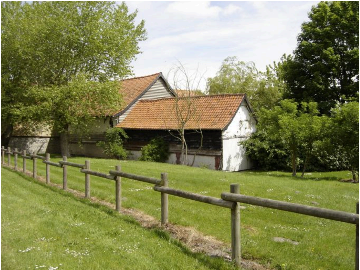
Vue sur la grange depuis la cour.
