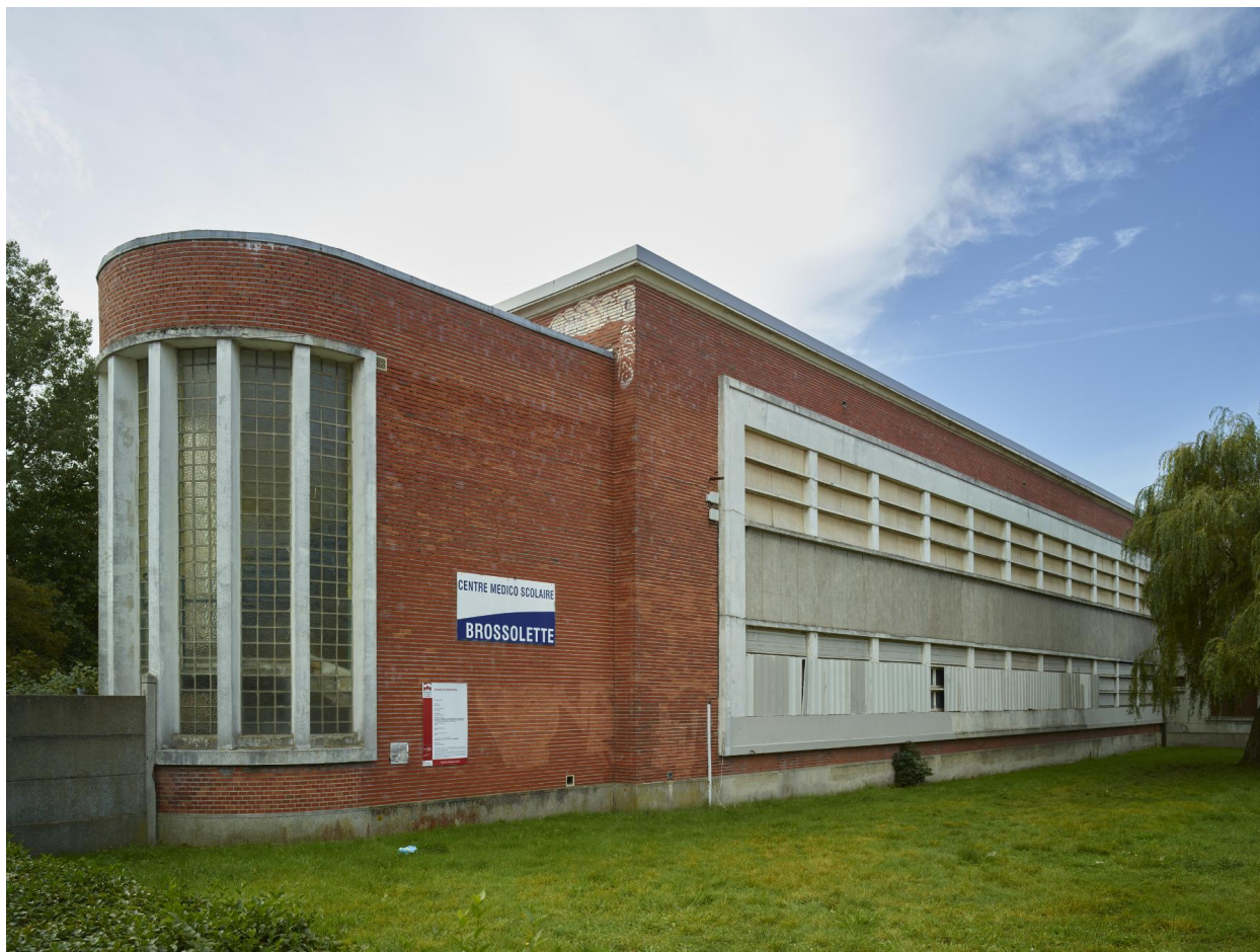
Cage d'escalier et élévation sur la rue du Docteur Zamenhof, vers le sud-ouest.
