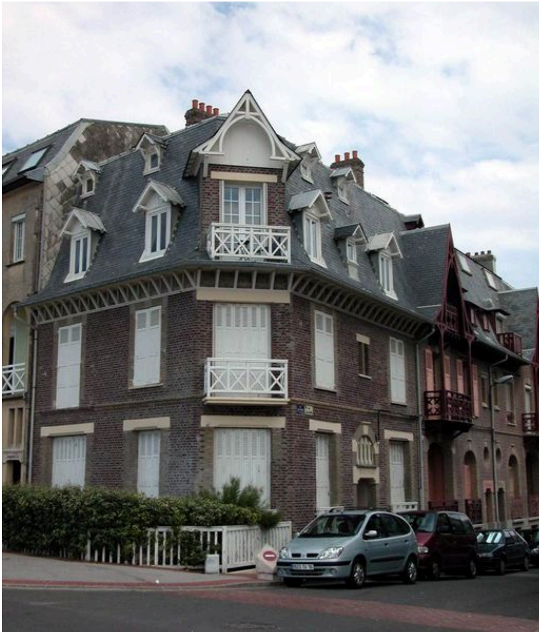
Vue d'ensemble depuis l'esplanade de la plage.
