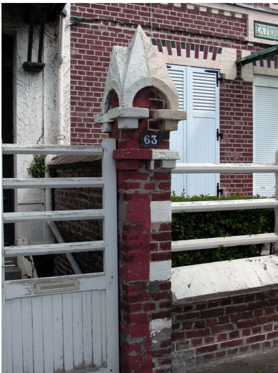
Détail d'un pilier du mur de clôture.
