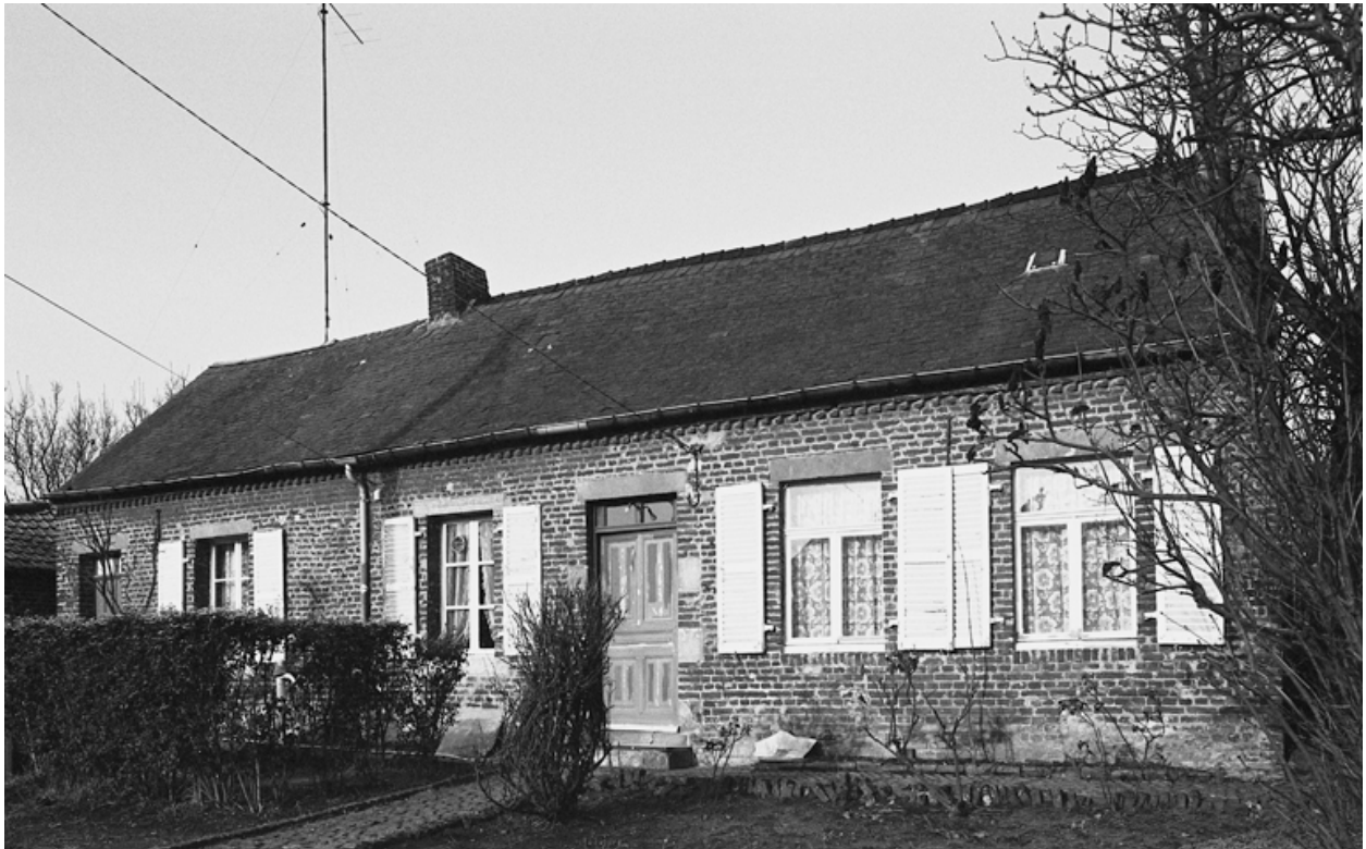
Vue d'ensemble de la façade.
