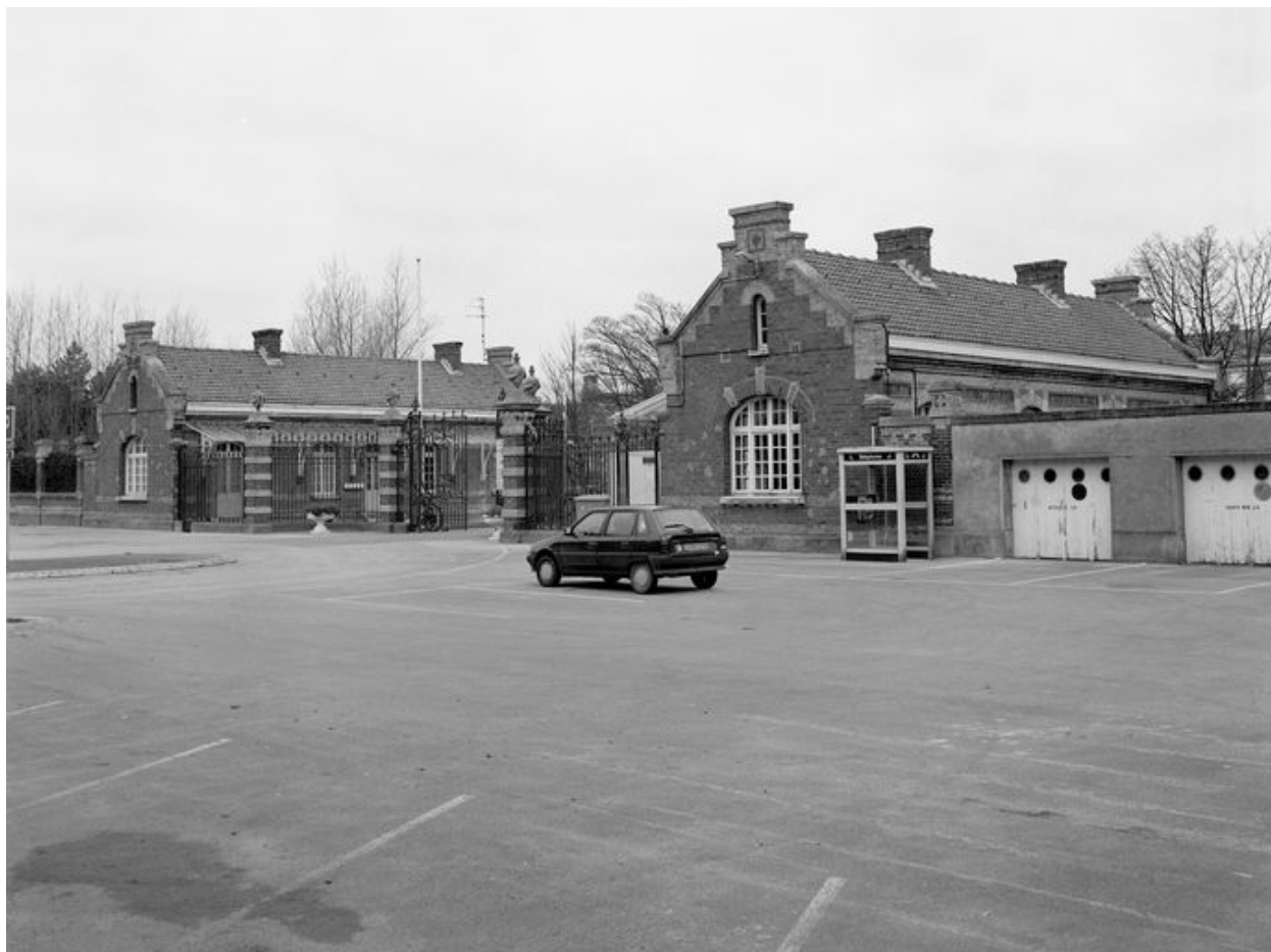
Pavillons d'entrée, vue d'ensemble des deux pavillons prise de l'intérieur de l'établissement depuis le nord-ouest.
