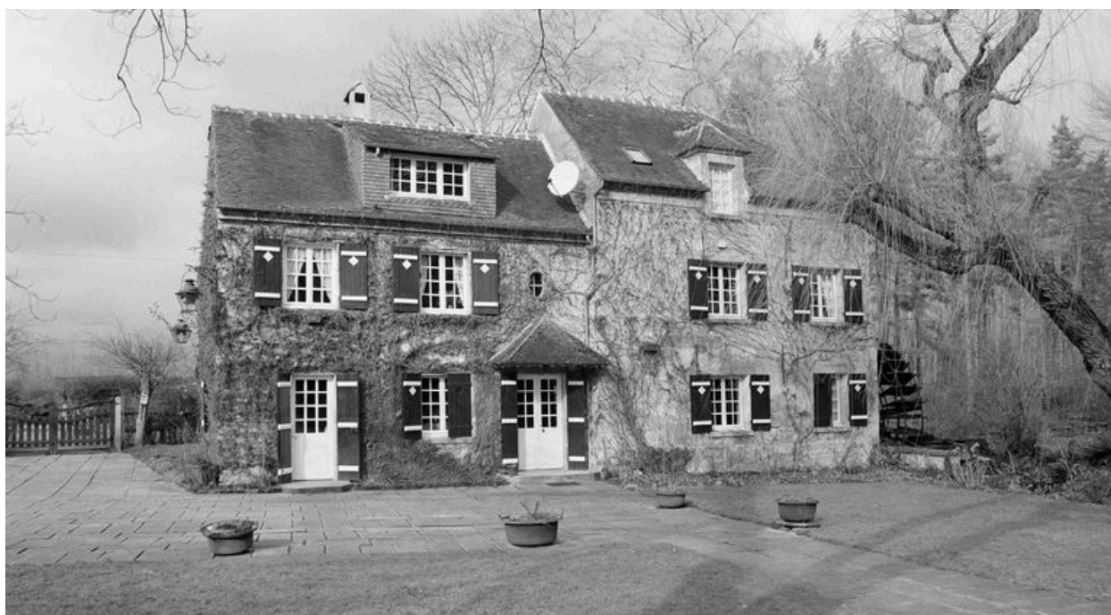
Vue générale du moulin : façade postérieure.
