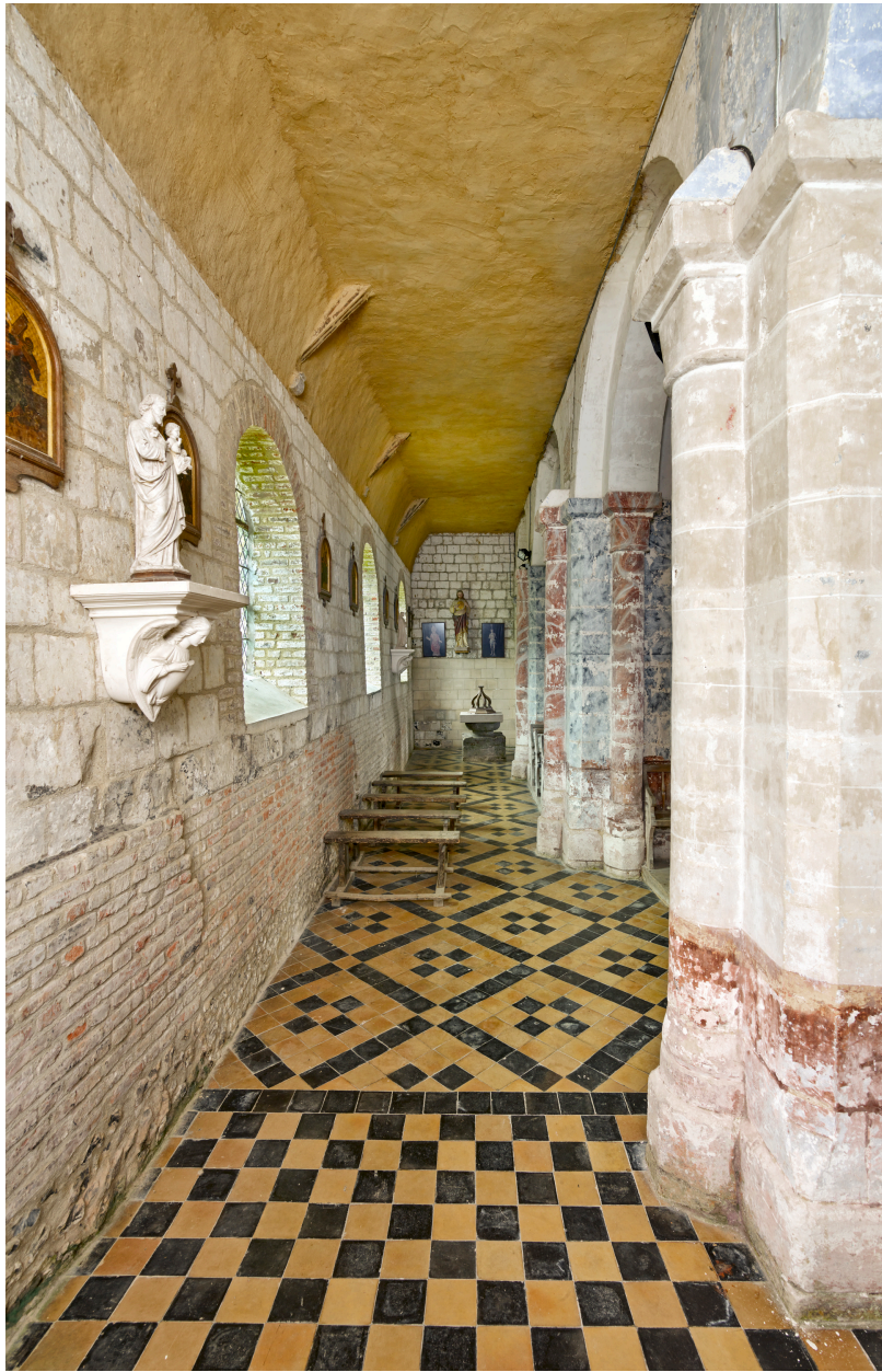
Intérieur, collatéral est, depuis le sud.
