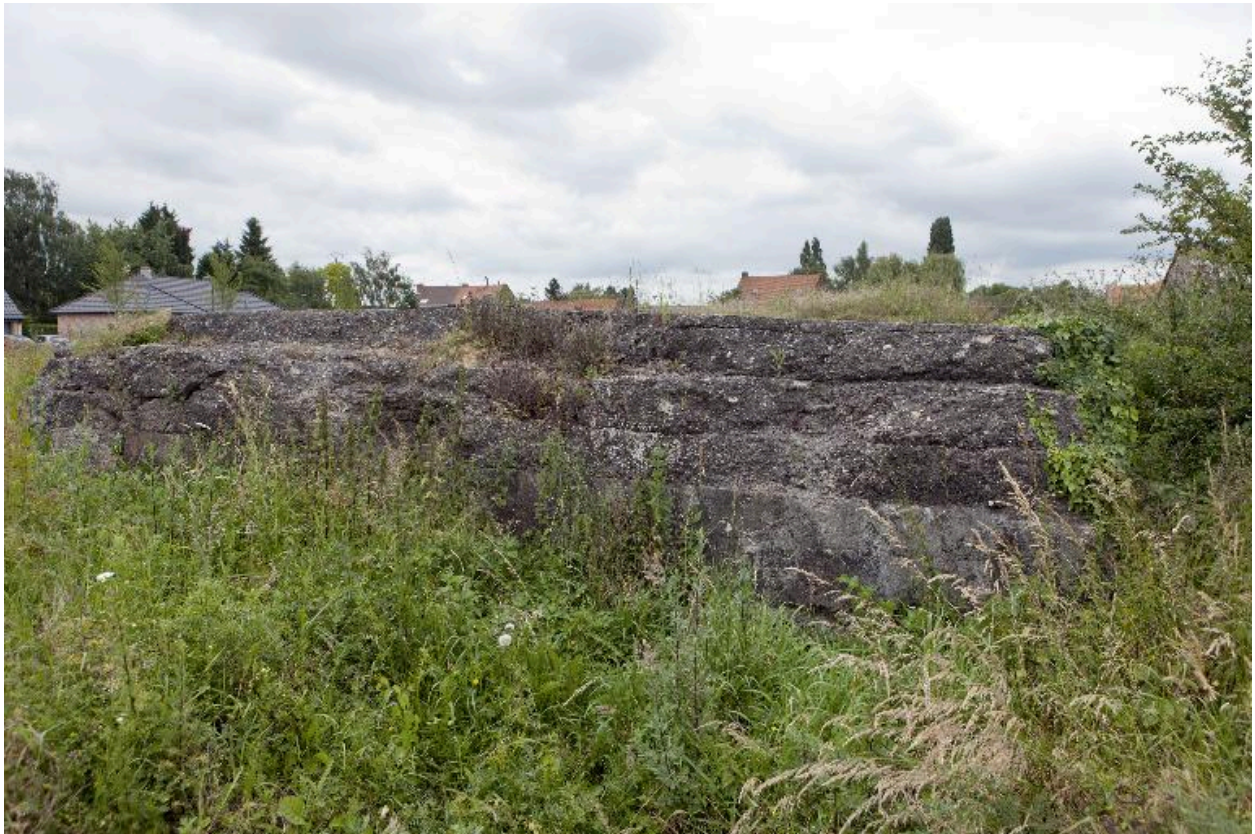
Casemate à personnel (Bat. B)
