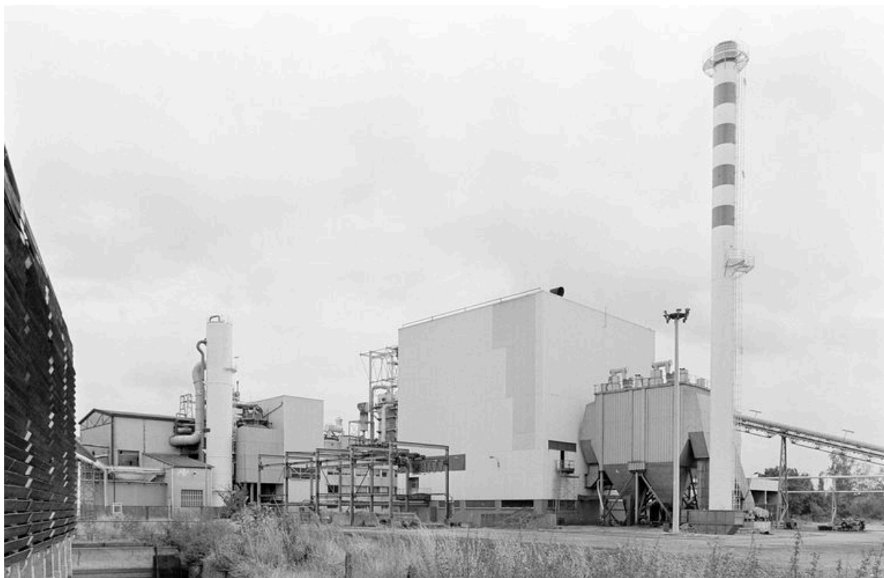
Vue générale de l'usine, flanc ouest.
