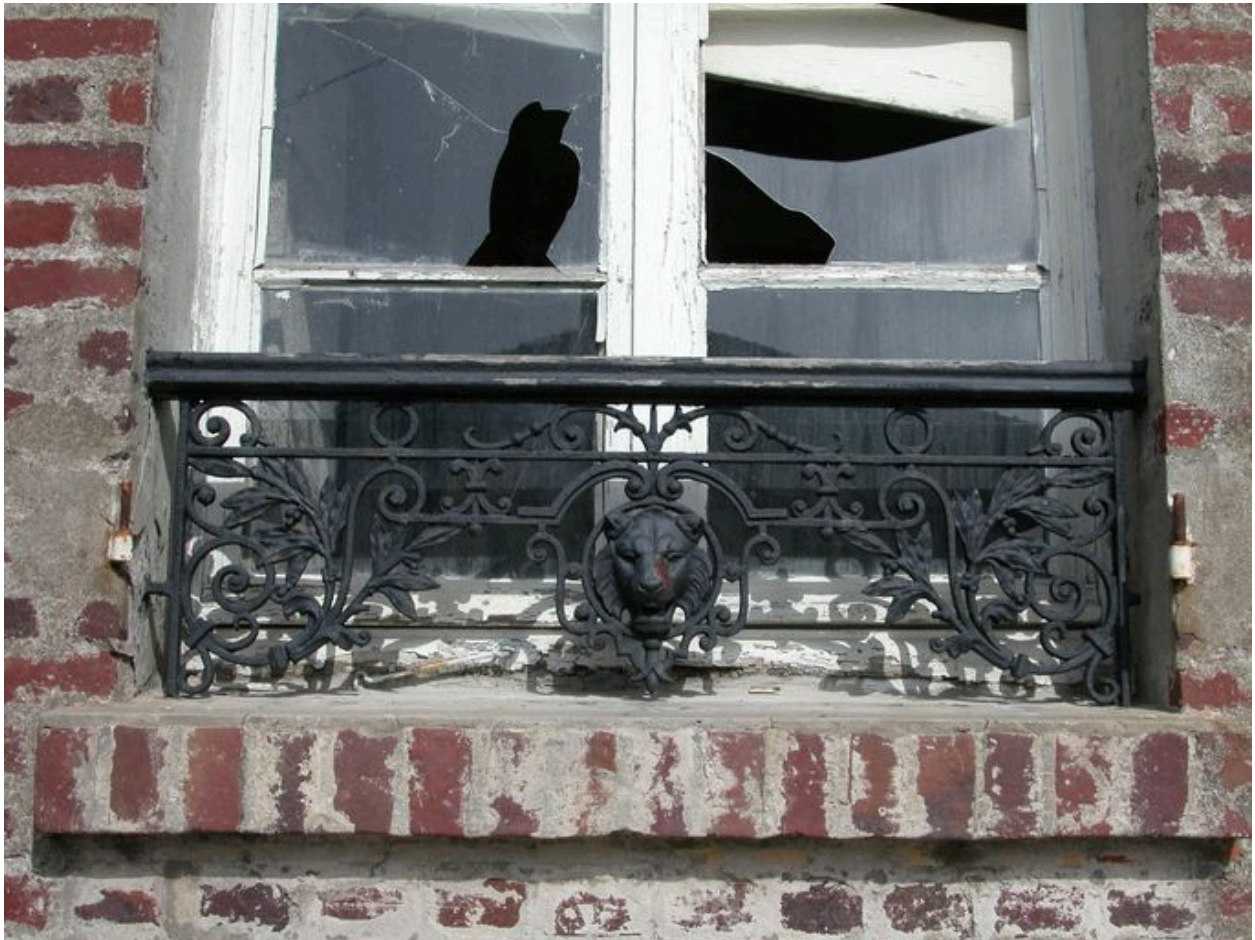
Détail d'un garde-corps en ferronnerie, rue Balzac.
