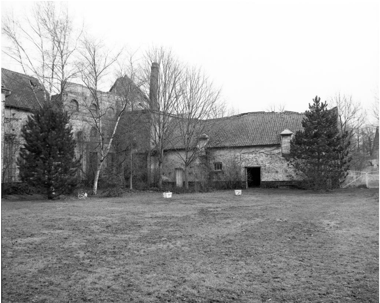
Ferme des Berceaux en 1999 : extrémité de la partie nord de la ferme(écurie), de celle nord-est (écurie porcherie) et de la cheminée de l'atelier de fabrication de noir animal vus depuis la cour.
