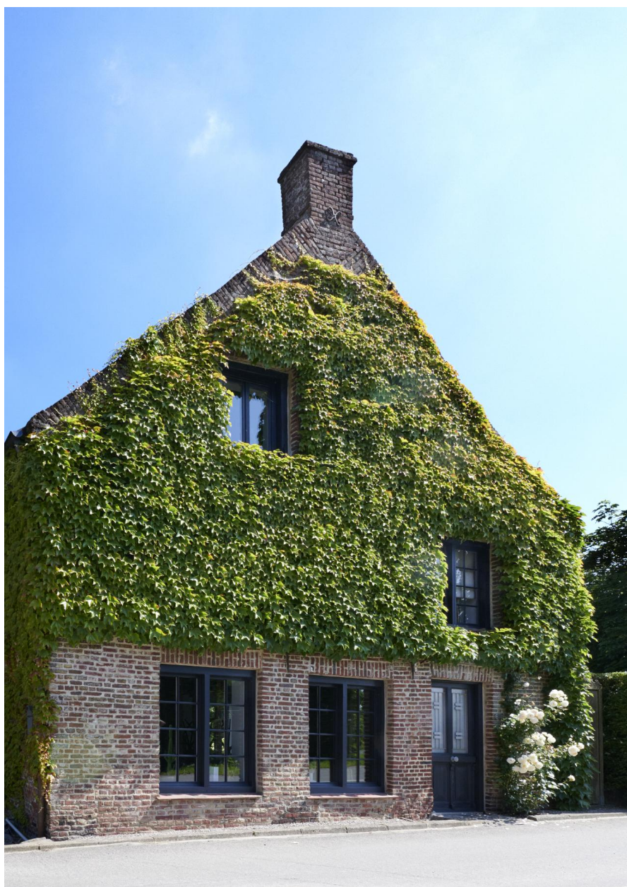
Façade sur rue du bâtiment.
