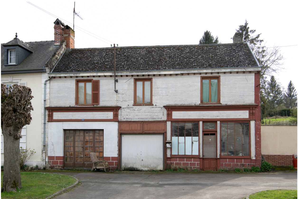
Ancien commerce, n°22 de la rue de la Ville, vue depuis le nord.
