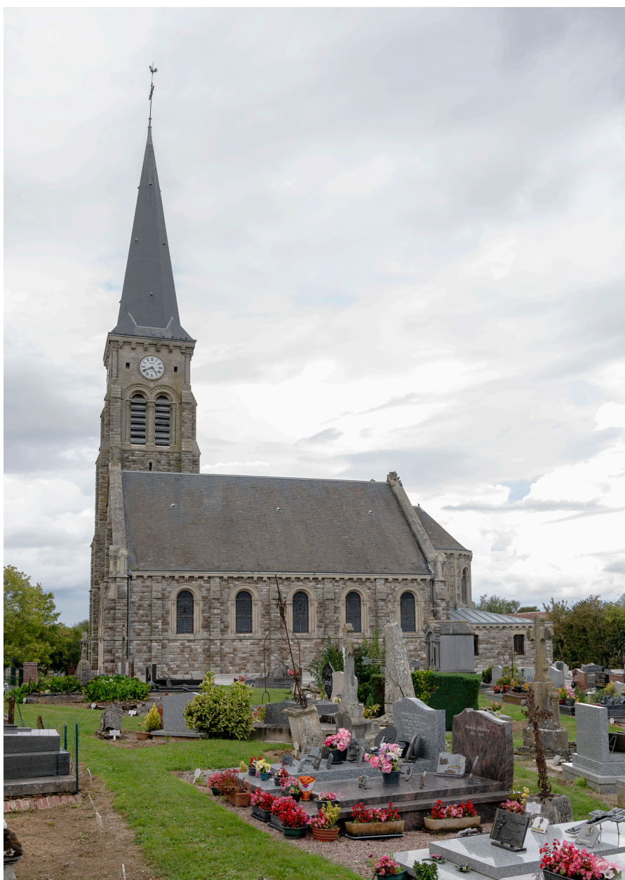
Vue générale depuis le sud.
