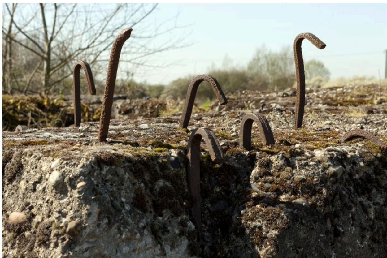
Bâtiment A : Partie explosée du toit, détail du ferrailage
